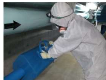
通水操作 (周辺補機棟 T.P. 2.3m)
