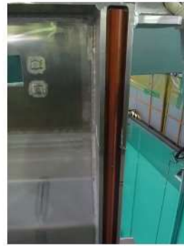
ゲートパッキンの装着状況
