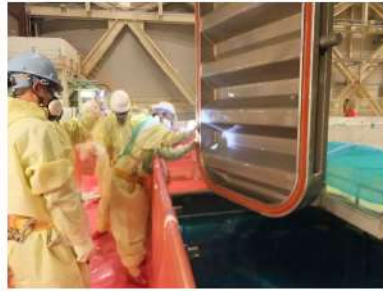
ゲートパッキン点検作業 (写真は2号機)
