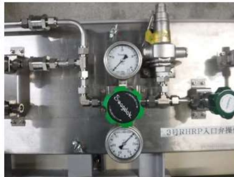
余熱除去ポンプ入口弁 空気供給圧力調整弁
