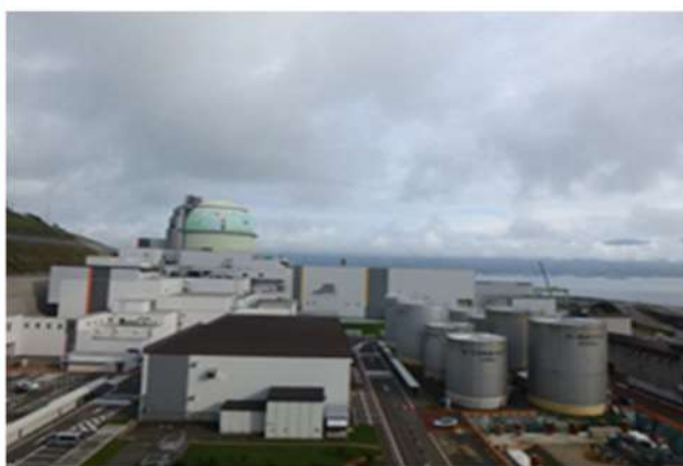
2号炉タービン建屋屋上
