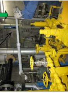
起動レバー（約 10 kg） 押し下げる
