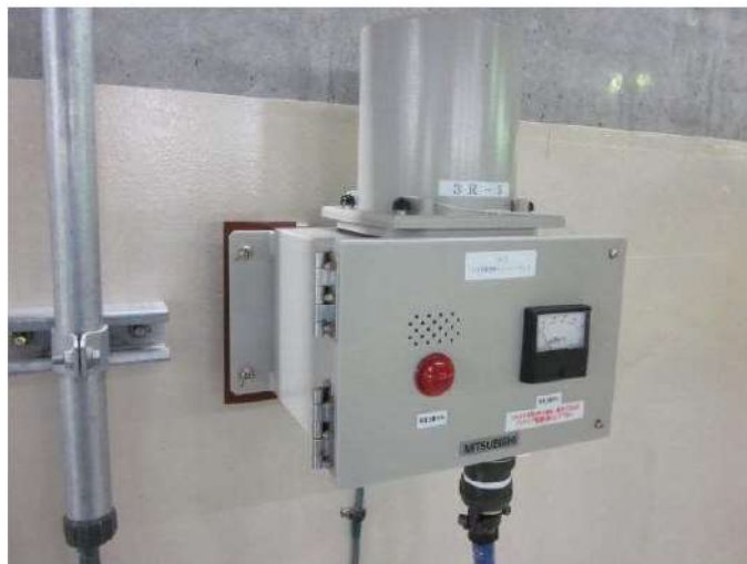
図2 機器のボルトによる壁面固定
