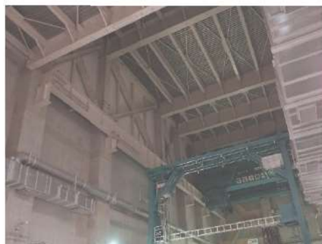
図 5.2.2 燃料取扱棟の屋根
