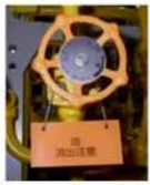
油類に係る弁 弁の識別
