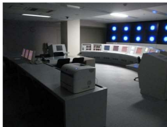
無停電運転保安灯点灯時
