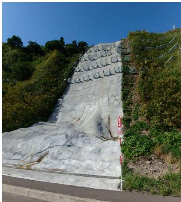
第1図 防火帯モルタル吹付工の施工例
