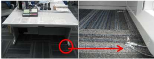
図10 運転員机の固定
