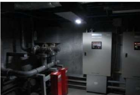
可搬型照明（ワークライト）を使用した状態
