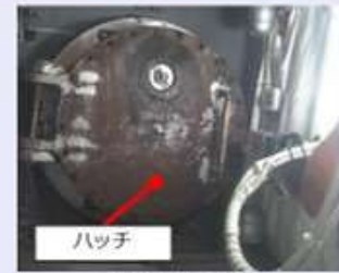
<ボルト除去作業の状況> (撮影日：2023年7月19日)
