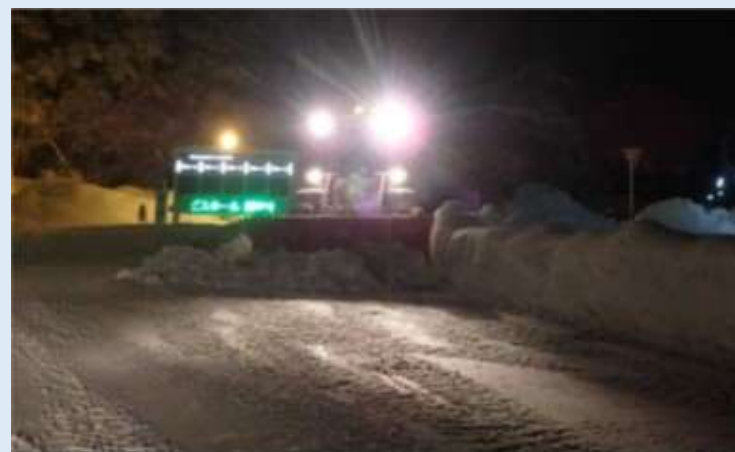
除雪車両による夜間の除雪作業
