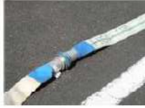
④ 可搬型ホース接続後
