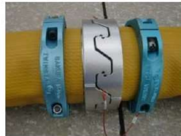
可搬型ホース（150A）接続後
