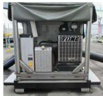
泡混合設備設置 (屋外)
