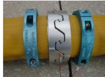
可搬型ホース(150A)接続後
