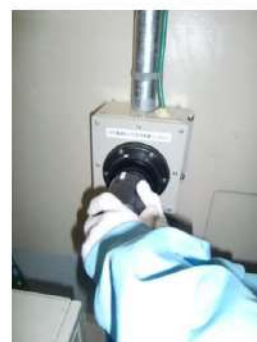
電源ケーブル接続
