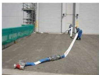
可搬型ホース敷設 （屋外）
