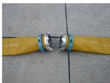
可搬型ホース(150A)接続前
