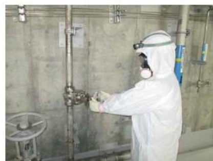
可搬型大型送水ポンプ車による原子炉格納容器下部への注水系統構成 （運転員（現場）C） （周辺補機棟 T. P. 10. 3m）
