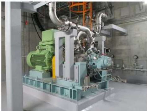
代替格納容器スプレイポンプ (周辺補機棟 T. P. 10. 3m)
