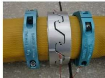
可搬型ホース(150A)接続後
