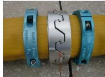
可搬型ホース (150A) 接続後
