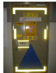
図 16 扉への反射テープ貼り付け例
