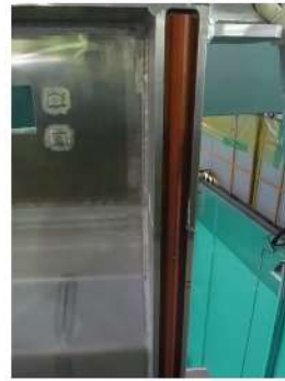
ゲートパッキンの装着状況
