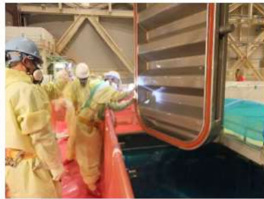
ゲートパッキン点検作業 (写真は2号機)
