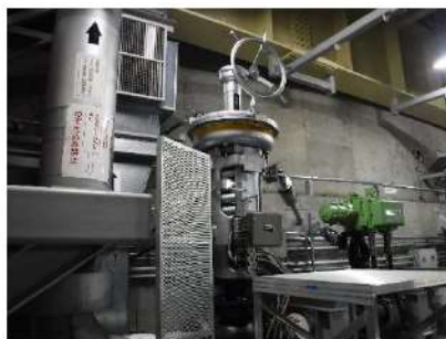
【図1 3B-主蒸気逃がし弁】
