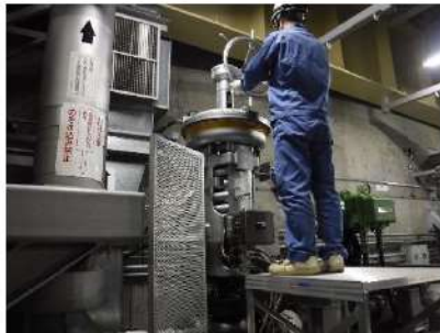
【図3 3B-主蒸気逃がし弁操作風景】
