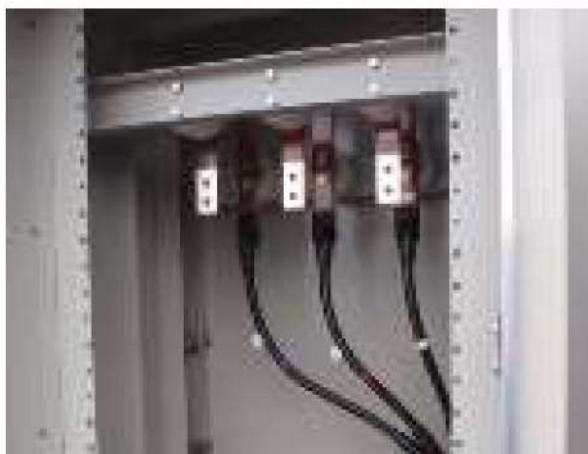
図 57.12.4 号炉間連絡予備ケーブル接続箇所
