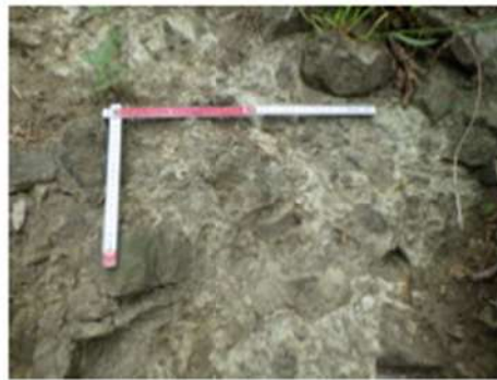
P4 防災科研調査において地滑り土塊末端部とされる箇所の露岩状況 堅硬な岩盤(凝灰角礫岩)が認められる。
