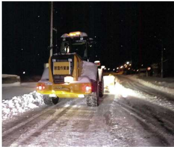
第4-2図 重機による除雪作業（2）
