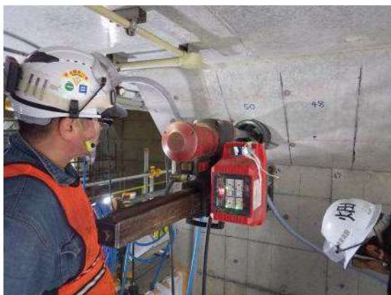
参考 2-1 図 削孔状況
