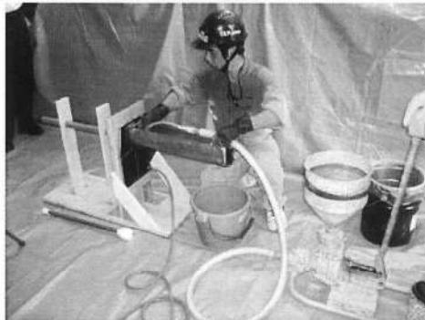
グラウトの充てん状況
