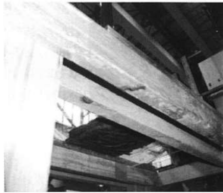
「セラミックキャップバー（CCb）」の設置
