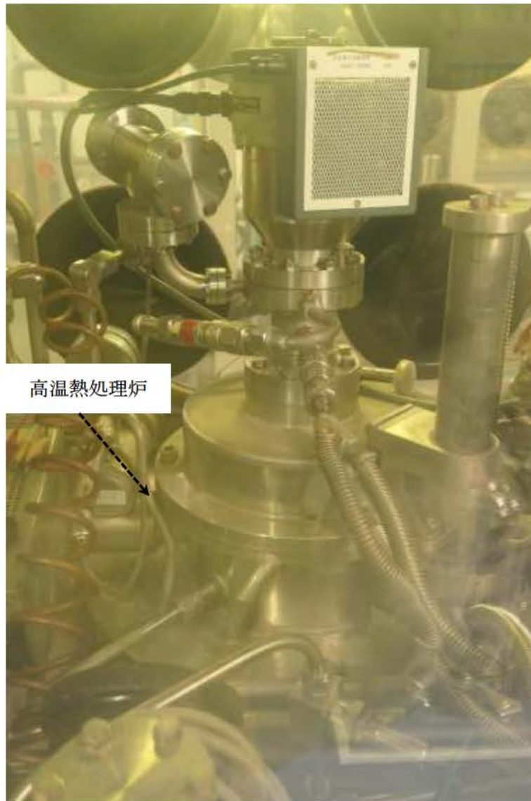
図-2-15 高温熱処理炉（201-D グローブボックス）の外観
