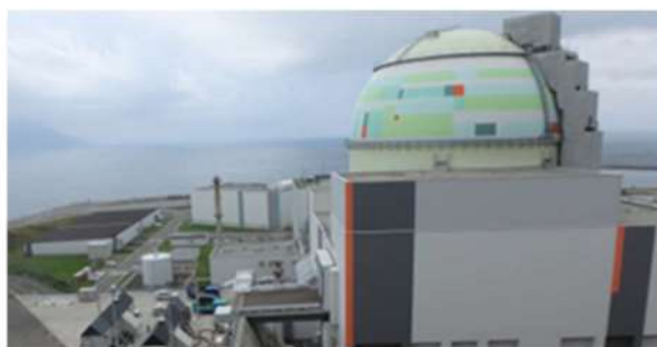
3号炉北東法面
