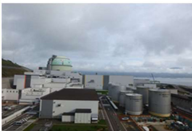
2号炉タービン建屋屋上
