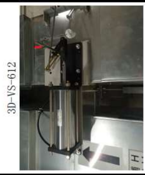
中央制御室排気隔離ダンパ
