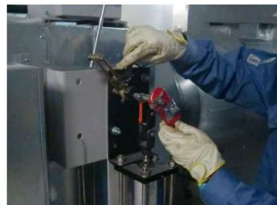
(空気作動ダンパ閉作業イメージ)
