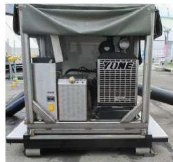
泡混合設備設置 (屋外)
