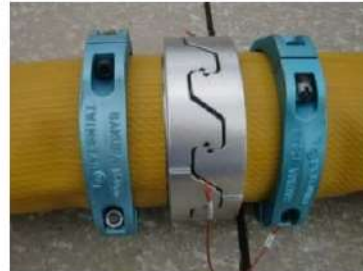
可搬型ホース（150A）接続後
