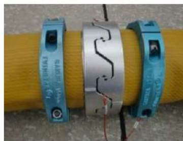
可搬型ホース（150A）接続後
