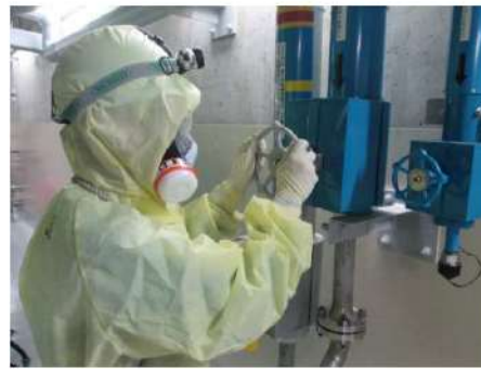
B-格納容器スプレイポンプ (自己冷却) 原子炉格納容器注水系統構成 (原子炉補助建屋 T.P. -1.7m)
