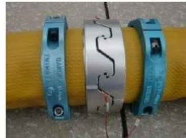
可搬型ホース（150A）接続後
