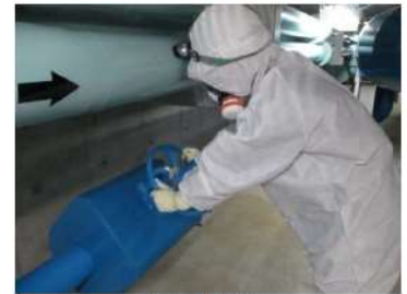
通水操作 (周辺補機棟 T.P. 2.3m)
