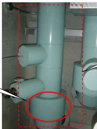
原子炉補機冷却海水系の ディーゼル発電機冷却配管取り外し、接続口設置 (ディーゼル発電機建屋 T.P. 6.2m)
