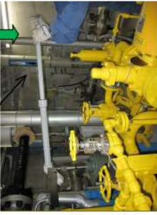
起動レバー (約 10 kg) 押し下げる
