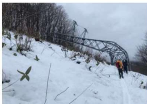
大雪による鉄塔倒壊事例 ※3
