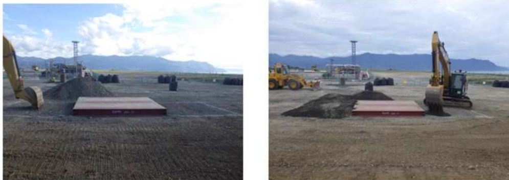
第10図 段差復旧状況
