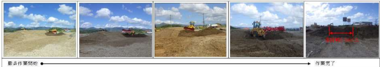
第5図 土砂撤去状況写真
