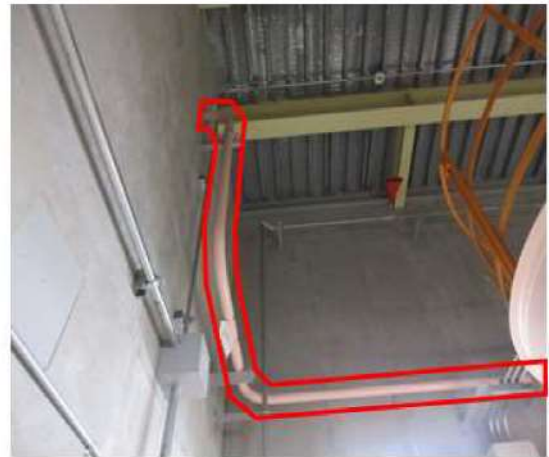
ディーゼル発電機燃料油サービスタンク 燃料油ベントライン (原子炉建屋敷設状況)
