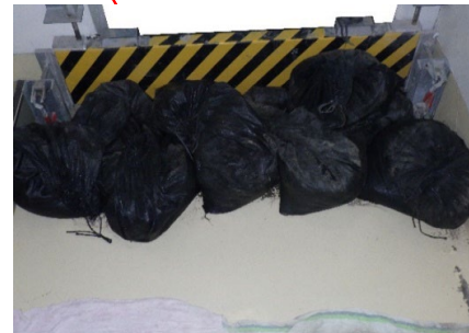
土嚢の設置状況
