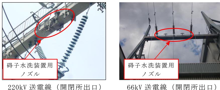
図 3-21 碍子洗浄装置外観
