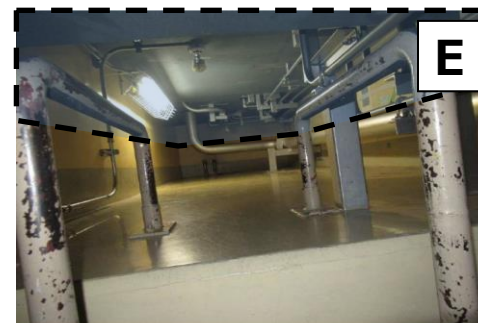
壁・天井等で区切られて生じた横穴（横穴部）
