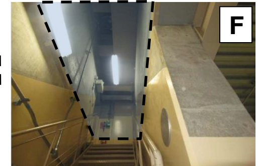
壁・天井により区切られた区画（階段室）
