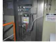
④ 復水ビット入口扉
