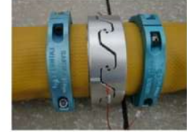
可搬型ホース（150A）接続後
