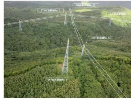
第2.2.3.5図 ③交差箇所の現地状況 (1/3)
