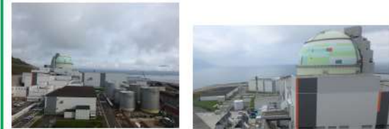
2号炉タービン建屋屋上
