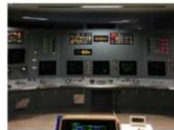
直流照明兼非常用照明点灯時のイメージ (写真：シミュレータ施設)
