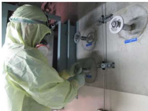
原子炉格納容器水素濃度監視系統構成 (周辺補機棟 T. P. 28. 0m)
