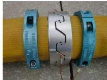
可搬型ホース (150A) 接続後
