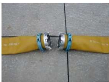
可搬型ホース (150A) 接続前
