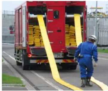
ホース延長・回収車（送水車用）による 可搬型ホース敷設 (屋外 T. P. 10.3m)
