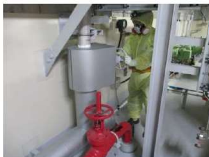
消火ポンプによる原子炉格納容器内へのスプレイ系統構成 （運転員（現場）B） （原子炉補助建屋 T.P. 10.3m）
