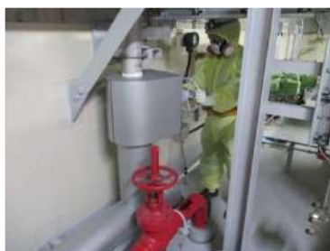
可搬型大型送水ポンプ車による原子炉格納容器内へのスプレイ系統構成 （運転員（現場）B） （原子炉補助建屋 T. P. 10. 3m）
