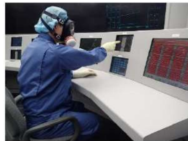
加圧器逃がし弁開操作 (中央制御室)
