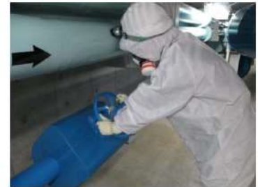
通水操作 (周辺補機棟 T.P. 2. 3m)
