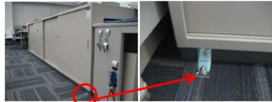
図11 キャビネットの固定
