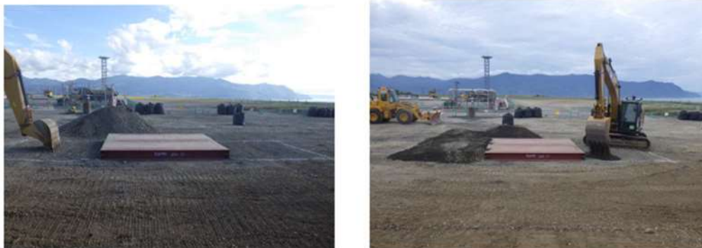
第10図 段差復旧状況
