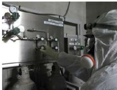
【図3 原子炉補機冷却水サージタンク加圧操作風景】
