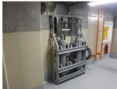
【図1 アニュラス全量排気弁等操作用可搬型窒素ガスポンプ】
