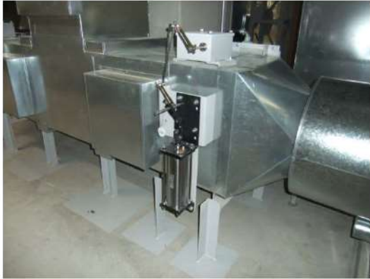
ダンパ全景 (原子炉補助建屋T. P. 24. 8m) (開操作対象ダンパの一例)
