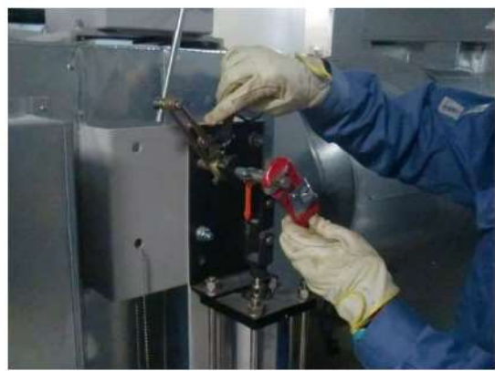
(空気作動ダンパ開作業イメージ)
