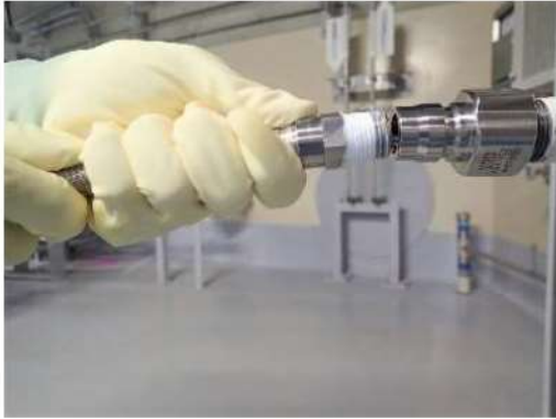
アニュラス排気ダンパのカプラ接続イメージ (周辺補機棟 T.P. 40. 3m)
