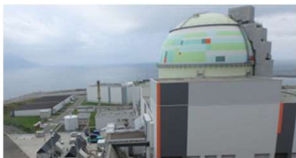
3号炉北東法面
